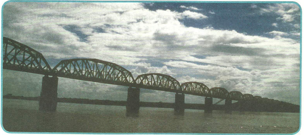
Estrutura de uma ponte
