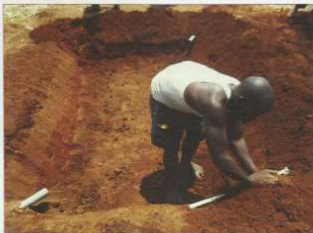
Fig 24. Nivelamento dos diques
