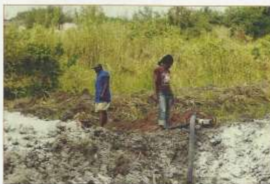
Fig 27. Enchimento do tanque
