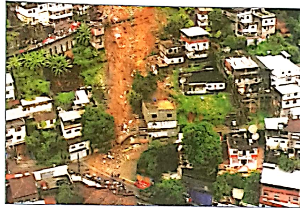
Fig. 166 Construção de casas em zonas impróprias
