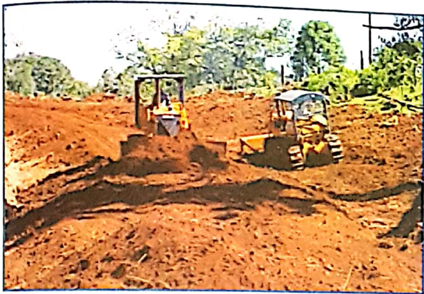
Fig. 165 Construção de estradas
